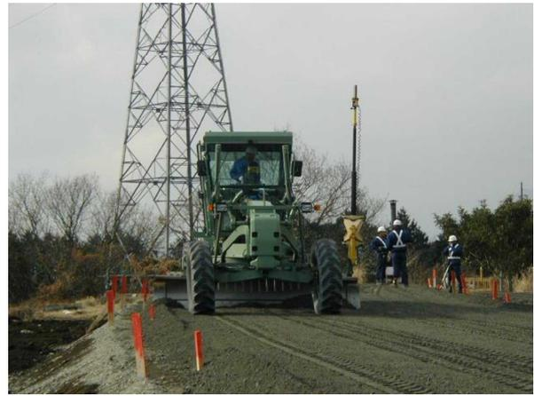
情報化施工での路盤整形状況
